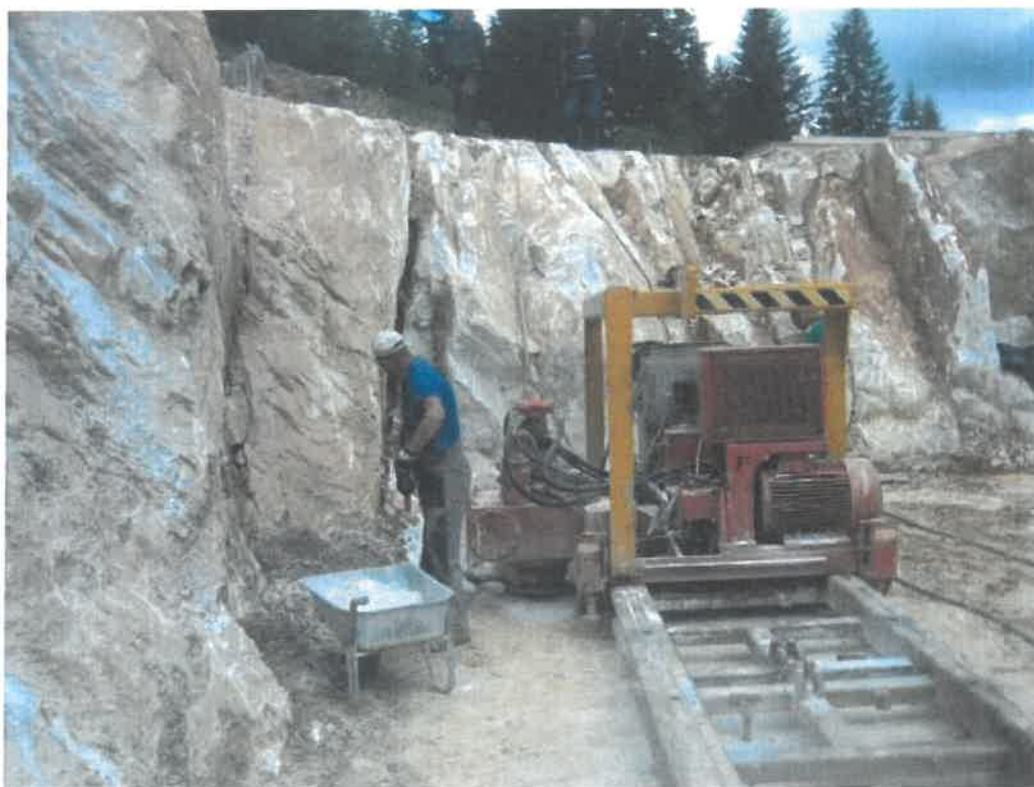
Slika 46. Lančana sjekačica - podsjekačica FANTINI SUD - 70 RAP u radu
